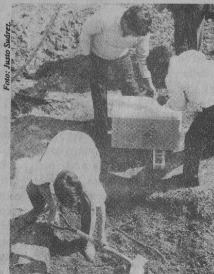
Inicio de una magna obra.
